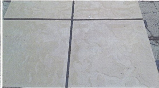
図4. タイル大 (なお、この写真では、タイル表面に 雨水が掛かっている)
